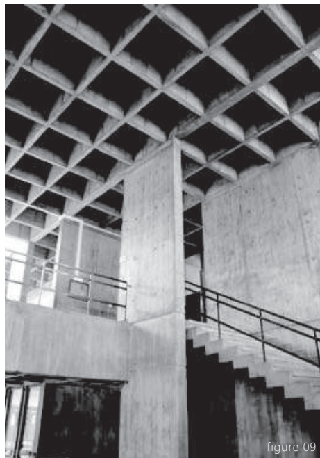
figure 09: 不對稱分散的剪力牆，柱子尺寸放大後變成牆體。figure 10: 格子樑的內嵌燈具。figure 11: 無結構力作用的預鑄空心磚立面。
