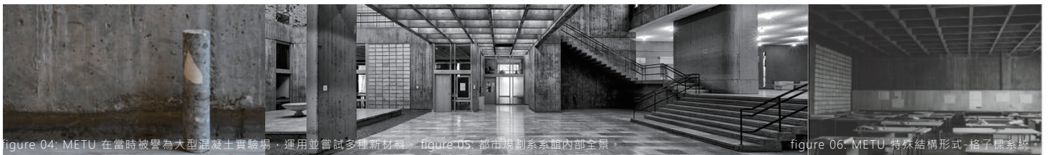
figure 04: METU 在當時被譽為大型混凝土實驗場，運用並嘗試多種新材料。 figure 05: 都市規劃系系館內部全景。
