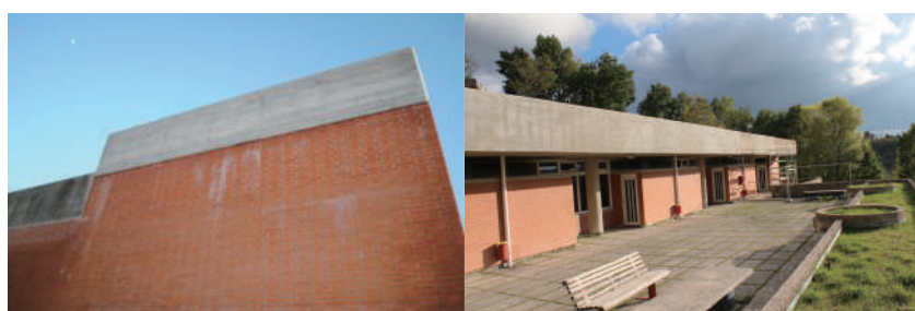
更複雜的修復使用模仿方法進行重建和修復；在“Aquilone”圖書館的第四層，使用木條塗裝表面以模仿原始混凝土模板的質感。
