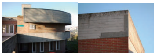
原建築師德卡羅設計的修復“補丁”被應用於“Tridente”建築的全面修復中，採用了雙層商業修復系統，並且與原始結構清晰區分。
